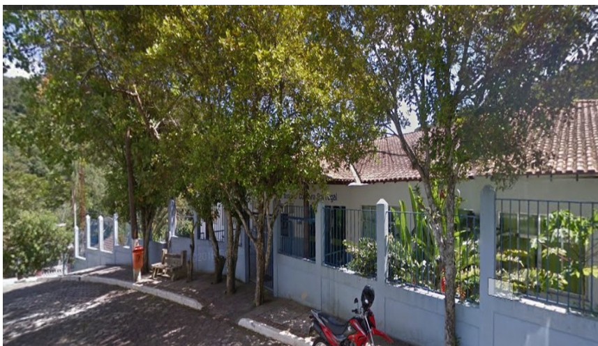
Figura 33 - Entrada da Escola Municipal Antônio Cordeiro Portugal
