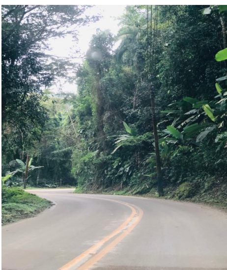
Figura 18 - Trecho asfaltado da Estrada RJ-14
