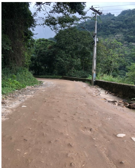
Figura 19 - Trecho original da Estrada RJ- 14 Fonte: arquivo da autora, 2022.
