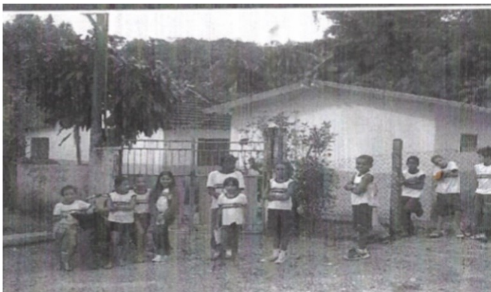
Figura 6 - Prédio da antiga Escola Fazenda da Lapa (1965)
