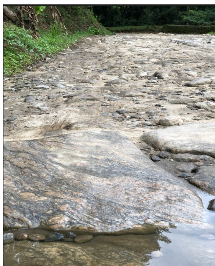
Figura 20 - Trecho original da Estrada RJ-14 feita em Pedra Pé de Moleque Fonte: arquivo da autora, 2022.
