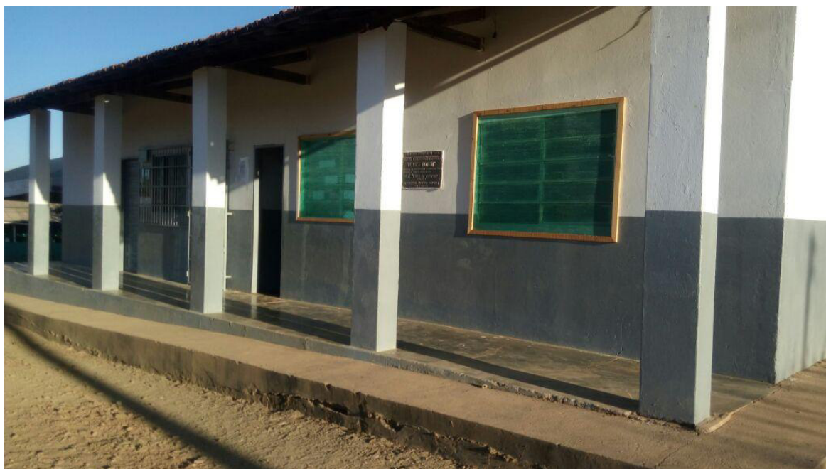
Figura 9 - Fachada da Escola Severino.
