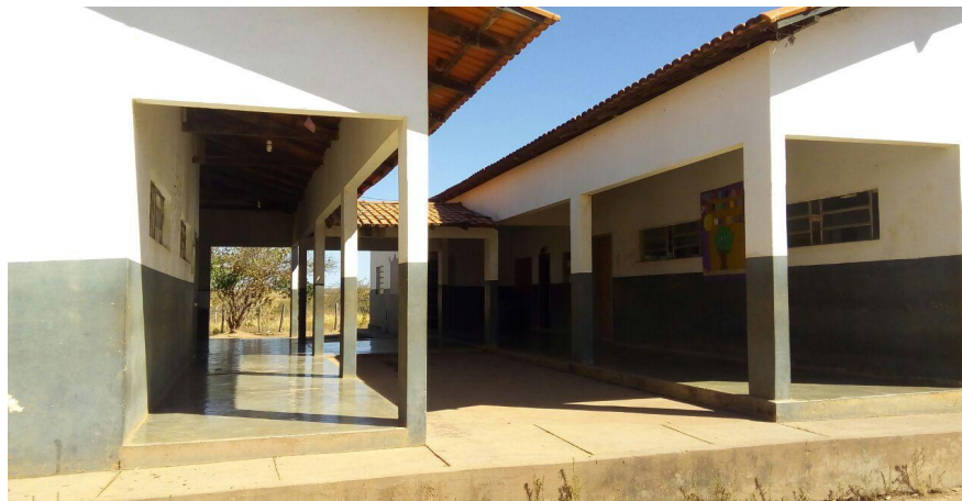
Figura 7 - Fachada da Escola Aureliano.
