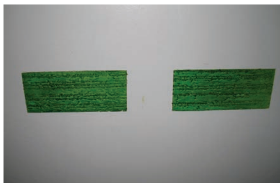
Foto 16 - A imagem mostra a sinalização nas paredes para dar direcionamento de rota. Ela tem textura e cor em contraste com a parede e está entrecortada para dar a oportunidade ao aluno de contar os pedaços e ter mais uma referência para chegar ao local desejado (Fonte: Ahimsa, 2004).
