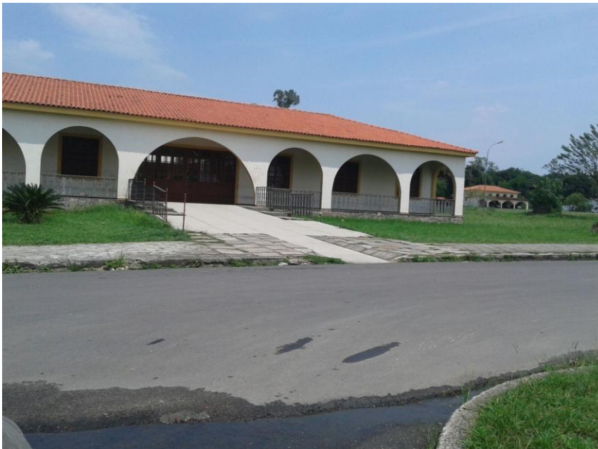
Figura 18: Prédio anexo ao Instituto de Ciências Exatas - Pavilhão Pitágoras
