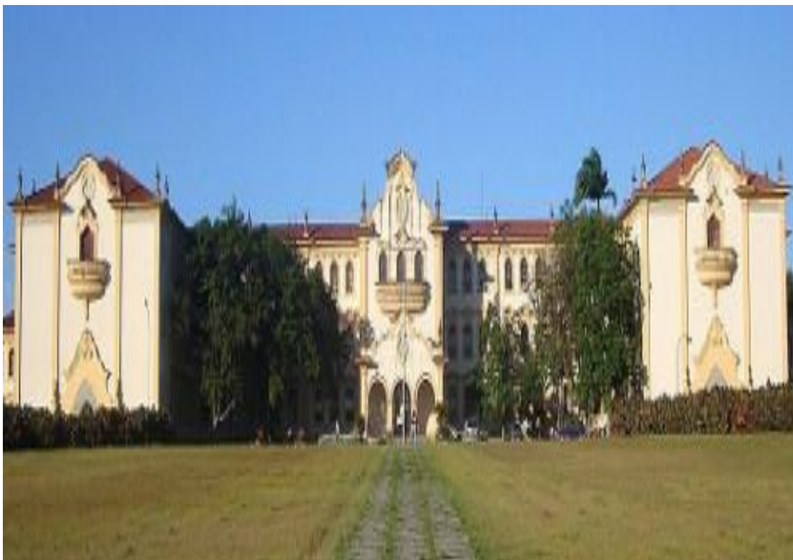
Figura 7: Pavilhão Central - P1
