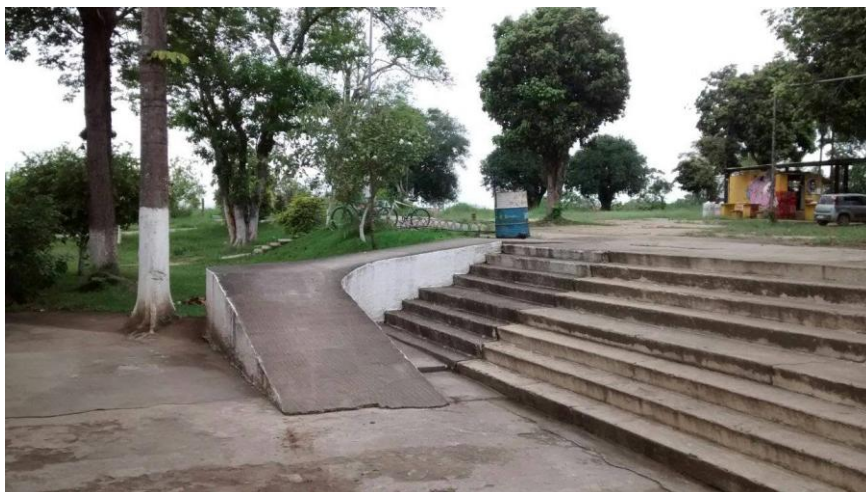
Figura 22: Rampa de acesso ao Restaurante Universitário R.U./Bandejão
