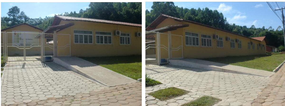
Figura 11 e 12 – Entrada do Prédio de aulas II
