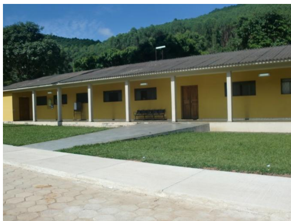
Figura 14 - Entrada do Prédio Administrativo do Campus
